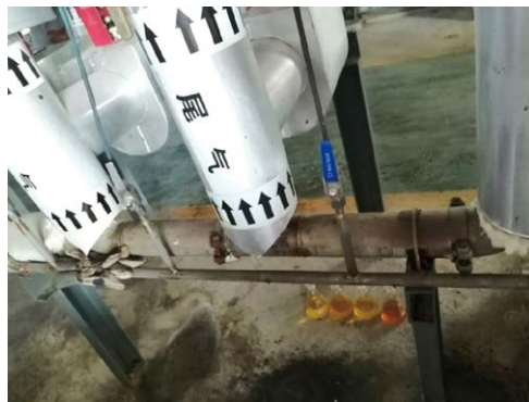
氮氧化物尾气管道上打了2个卡子
