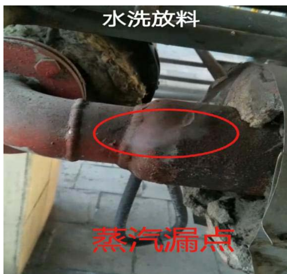
图1 蒸汽漏点图片
