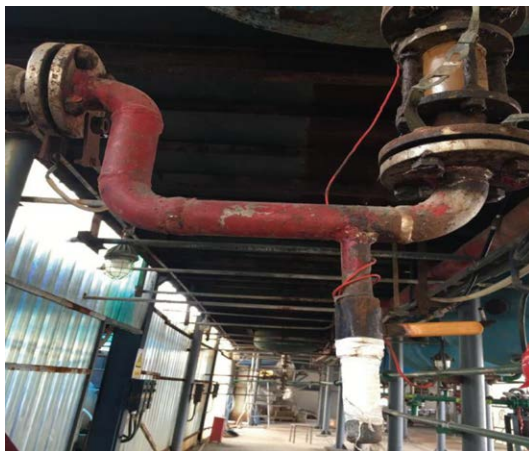
采样口未设置双阀门控制。
