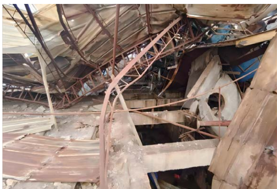
检修冰机发生燃爆，冰机西侧密闭地下池盖板炸飞，房顶坍塌
