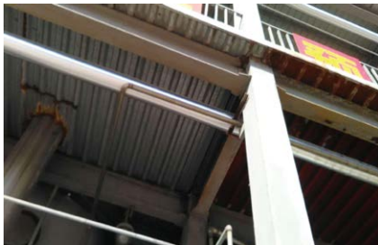
甲醇管道进装置区未进行静电接地。
