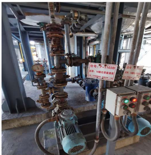
酯化塔釜液泵出口管道上未设置止回阀。
