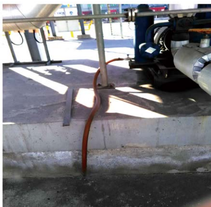
液氨卸车压缩机入口气液分离器排液未密闭回收。
