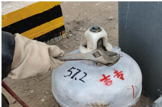
气体切割作业人员未使用专用工具开启乙炔气瓶。
