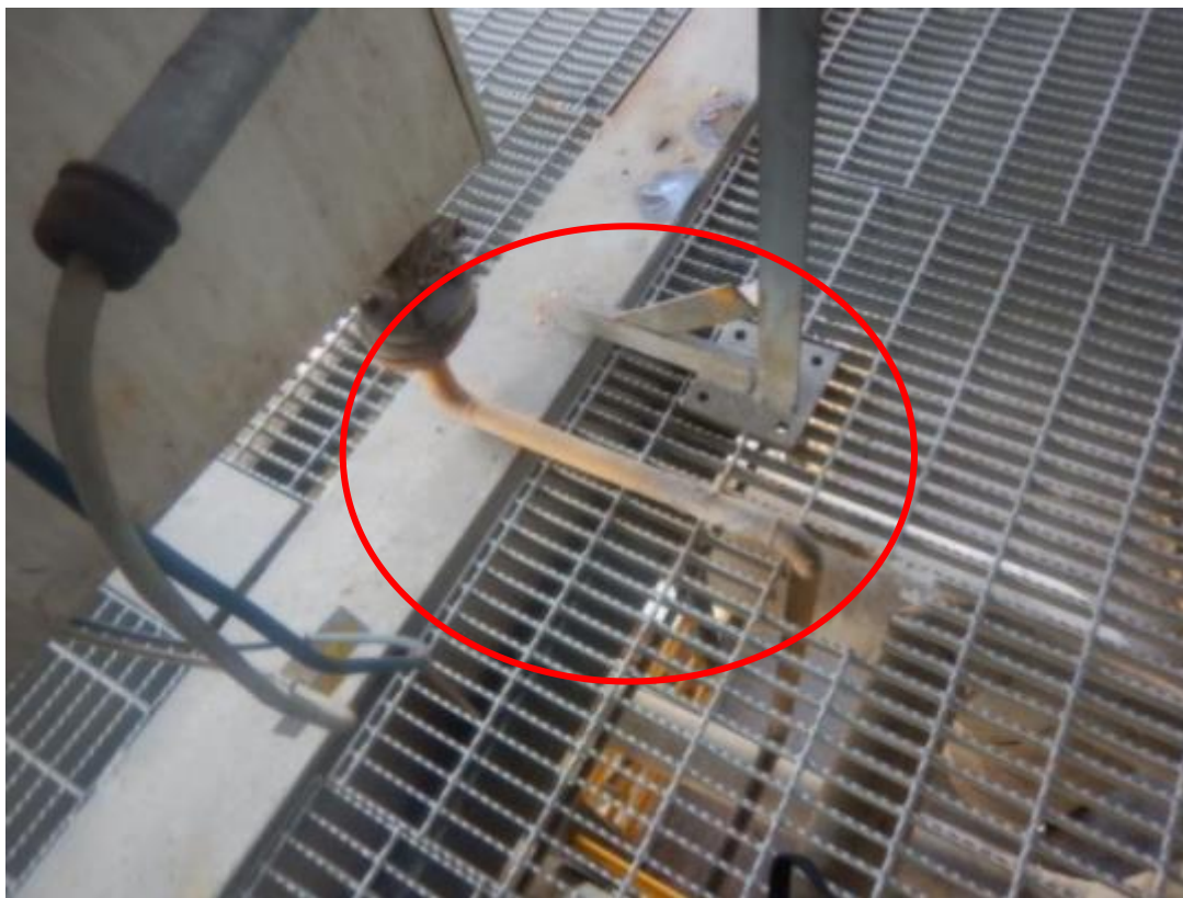
某车间新增氮气吹扫管线，未执行变更程序
