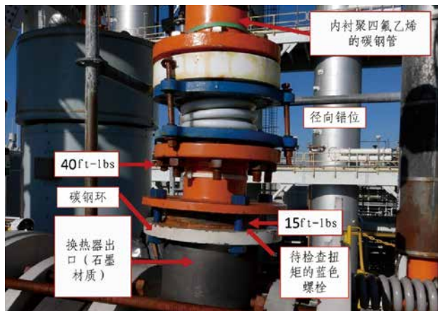
图 2 HCl 气体泄漏处（图片来源：CSB 调查报告）
