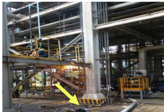
地沟没有完全封堵
